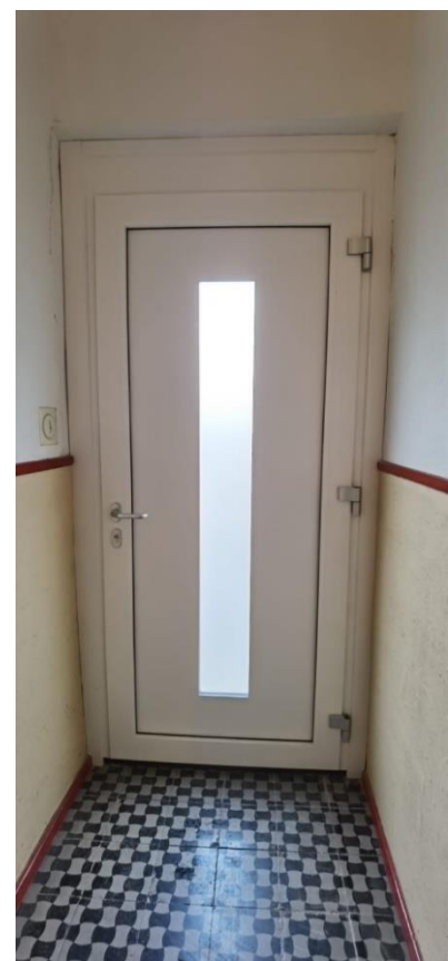
neue Haustür – Straßenseite – innen
